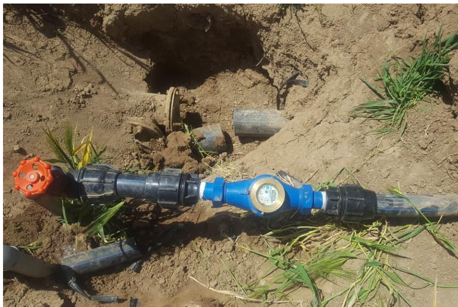
شکل ۱- نصب کنتور در مزارع آبیاری قطره‌ای برای اندازه‌گیری حجم آب آبیاری
