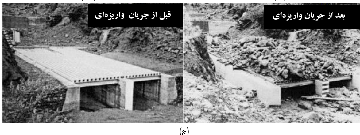
شکل ۱- نمای شماتیک از عملکرد سازه متوقف‌کننده، (الف) سازه متوقف‌کننده جریان واریزه‌ای قبل از وقوع جریان واریزه‌ای، (ب) سازه متوقف‌کننده جریان واریزه‌ای بعد از توقف بخشی از جریان واریزه‌ای و (ج) سازه متوقف‌کننده در دره کامی کامی-هوریزاوا کوه یاکداک ژاپن (Gonda, 2009; Yifru et al., 2018)
