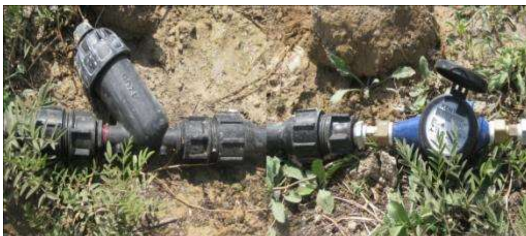
شکل ۲- فیلتر دیسکی و حجم سنج
