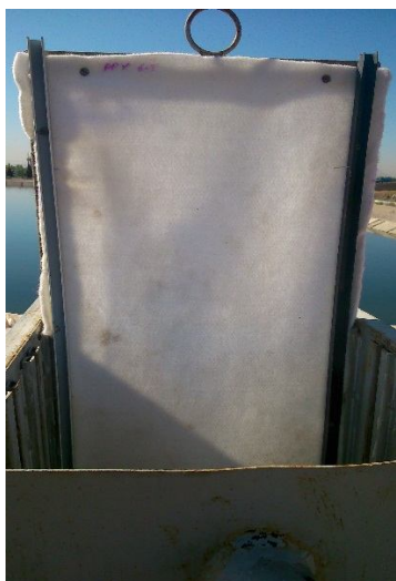
شکل 1- نصب و کارگذاری فیلتر ژئوتکستایل PPV 6.5
