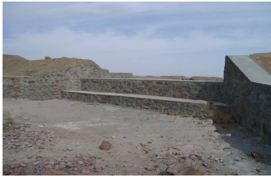
شکل 2: سازه سرریز پلکانی صلب (مصالح سنگ و سیمان)
