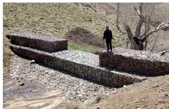
شکل 1- سازه سرریز گابیونی با یک پله
