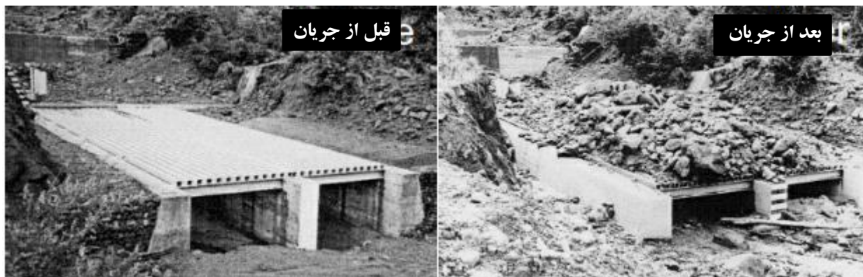
شکل ۱- سازه متوقف‌کننده جریان واریزه‌ای در دره کامی - هوریزاوا از کوه یاکداک ژاپن (Gonda, 2009)
