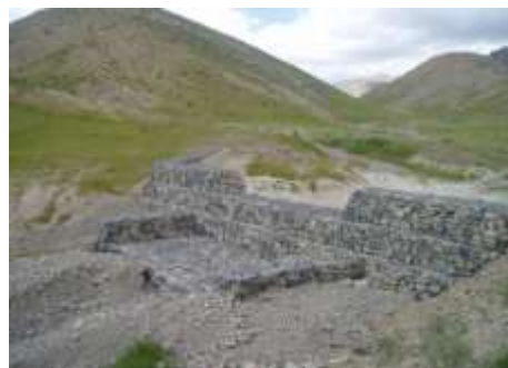
شکل ۱- سازه سرریز گابیونی با دو پله
