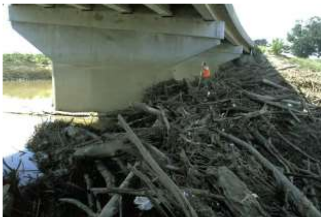
شکل ۱- تجمع واریزه در پشت پایه پل و مسدود شدن مسیر عبور جریان [Diehl., 1997]
