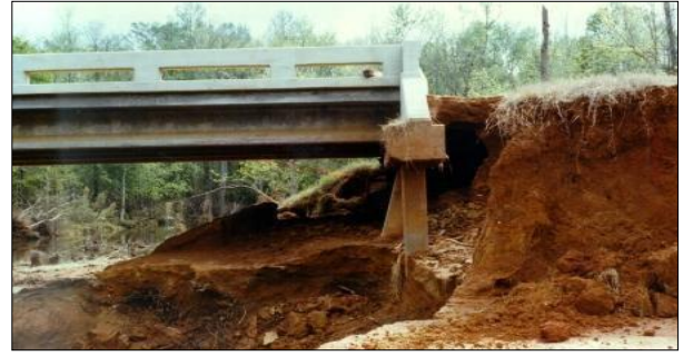
شکل ۱- نمونه از آبستگي پایه‌ی پل.
