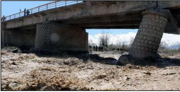
شکل ۱- نمونه از آبستگي پایه‌ی پل.
