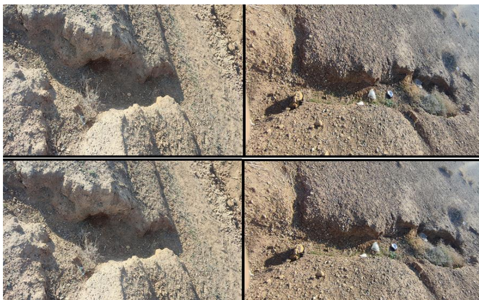
شکل ۹ - ترک های شکل گرفته در قسمت جنوب شرقی منطقه
