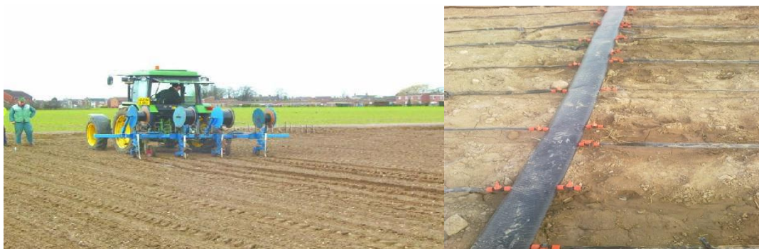
شکل ۱- پهن کردن لوله‌های تیپ با ماشین و نمایی از اجرای انجام شده
