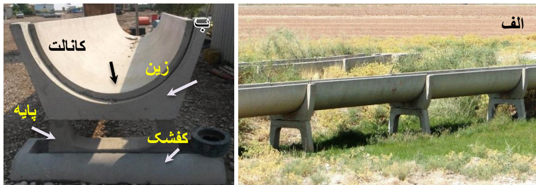
شکل ۱- الف- نمایی از کاربرد کانالت در شبکه آبیاری سبیلی خوزستان و ب- اجزای تشکیل دهنده کانالت
