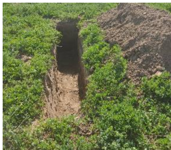
شکل ۲- حفر ترانشه و شستشوی خاک اطراف لوله‌ها، جهت بررسی گرفتگی قطره‌چکان‌ها (پایان سال سوم)
