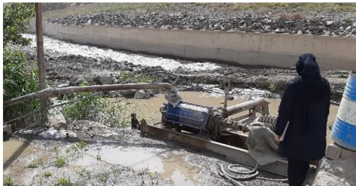
شکل ۵- نمونه پمپاژ و برداشت آب از رودخانه هراز
